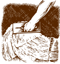
FIG. 1 เตรียมพื้นผิวผนังที่จะติดตั้งหินให้แข็งแรง และสะอาด ปราศจากฝุ่นและน้ำมัน
