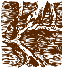
FIG. 9 ใช้ไม้กวาดหรือแปรงขนอ่อนปัดกวาด เศษปูนออก และทำความสะอาด
